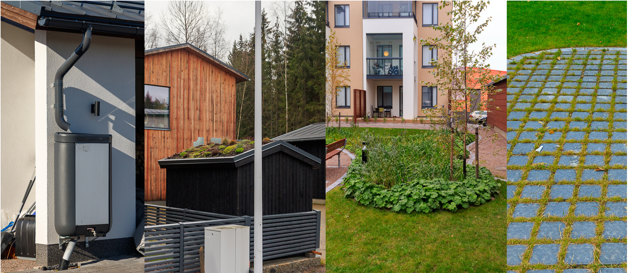
Hulevesien käsittelyyn on monta ratkaisua. Tässä kuvasarjassa kattovesisäiliö, viherkatto, hulevesipainanne ja vihersaumattu kivetyks.
